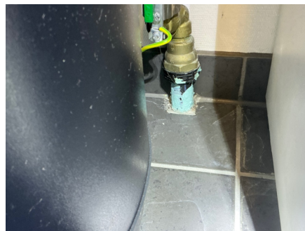
Synlig smøre-membran på vannrør
