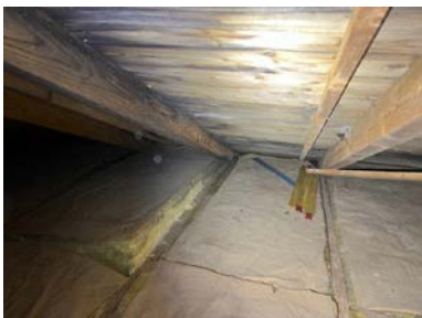
Misfarging takstoler og undertak.
