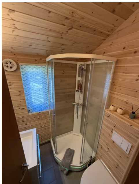
Vegger har trepanel i våtsoner.
