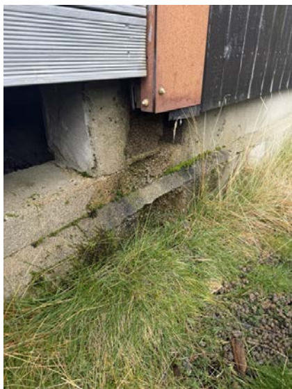
Taknedløp er avsluttet over bakken. Disse er innkasset i cortenstål og derfor ikke synlig på bilde.
