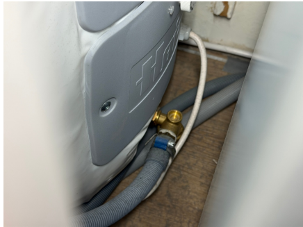
Avrenning er tilkoblet avløp.
