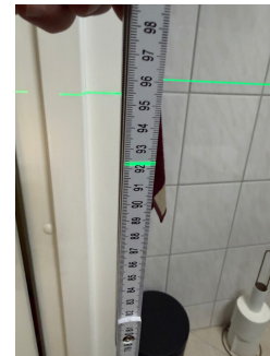
Topp flis ved dør 92,4 cm. Som gir et fall på 25 mm til sluk.
