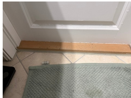
Ingen tilluft under dør
