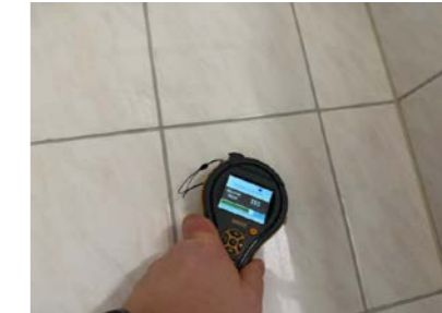
Vegg mot sovealkove, ingen utslag.
