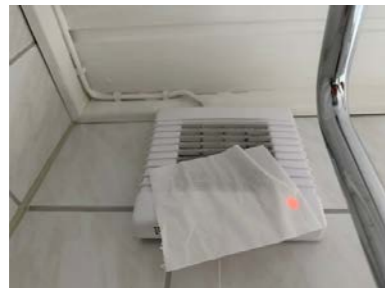
Funksjonstest av avtrekk
