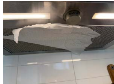
Funksjonstest av avtrekk
