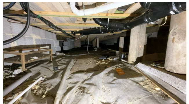
Besiktigelse av kryprom.
