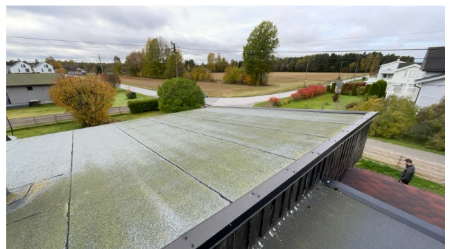
Besiktigelse av taktekke.
