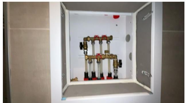
Besiktigelse av røropplegg.
