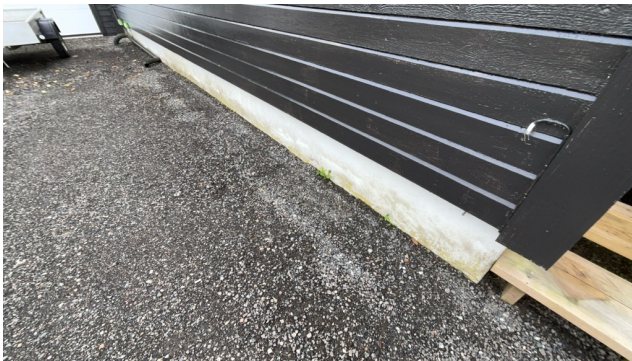
Kontroll av drenering/fuktsikring.
