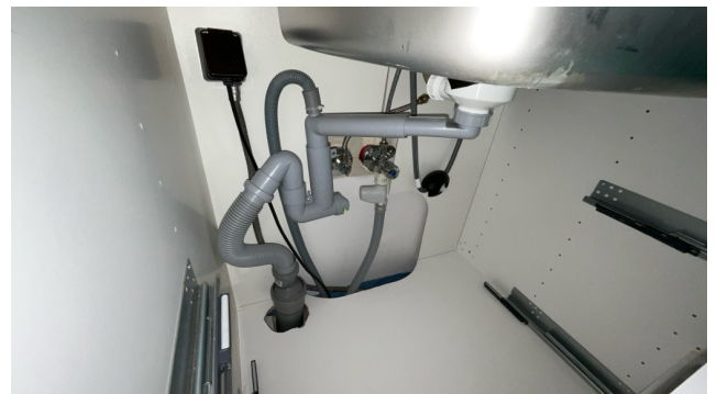
Besiktigelse av røropplegg.
