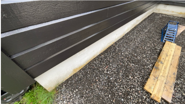
Kontroll av drenering/fuktsikring.
