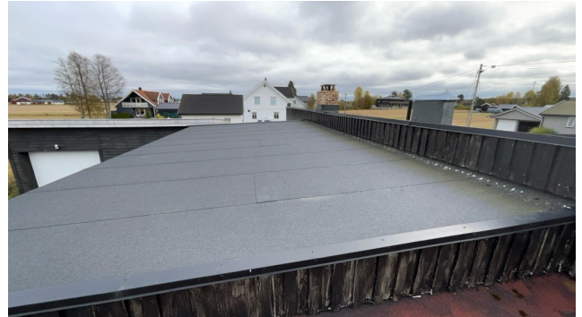
Besiktigelse av taktekke.
