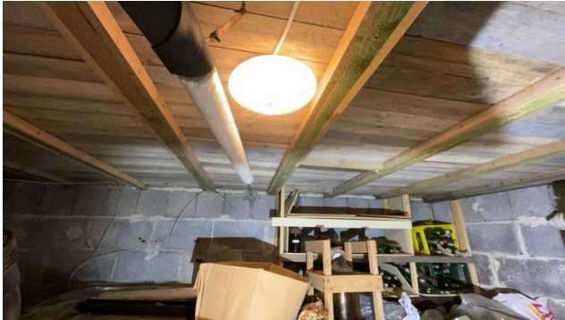
Besiktigelse av kryprom.
