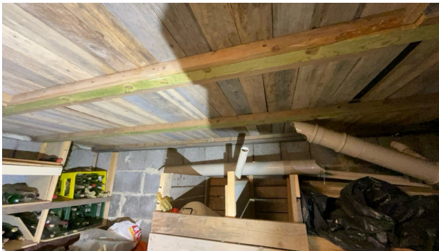
Besiktigelse av kryprom.
