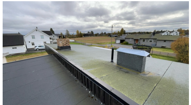
Besiktigelse av taktekke.
