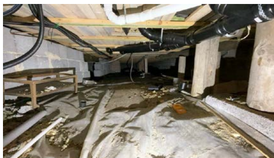
Besiktigelse av kryprom.
