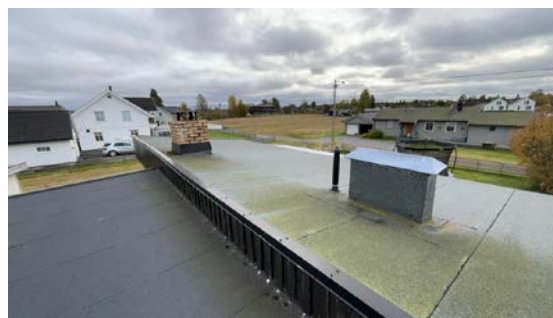
Besiktigelse av taktekke.
