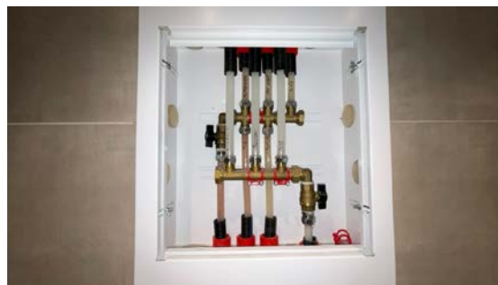
Besiktigelse av røropplegg.
