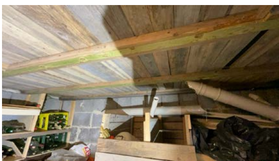
Besiktigelse av kryprom.
