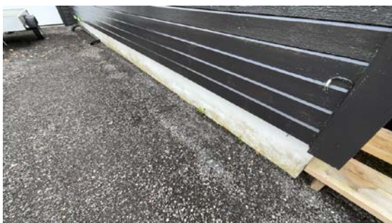
Kontroll av drenering/fuktsikring.
