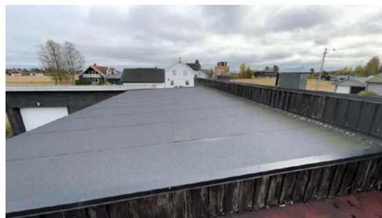
Besiktigelse av taktekke.
