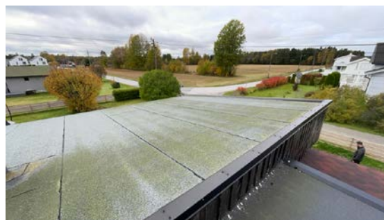
Besiktigelse av taktekke.
