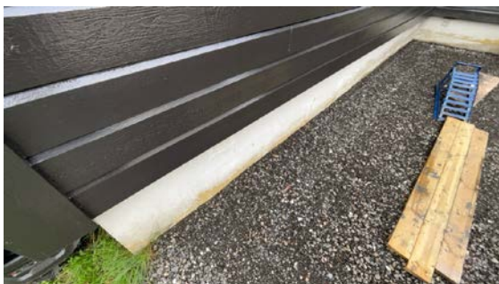
Kontroll av drenering/fuktsikring.
