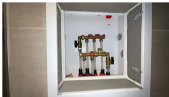
Besiktigelse av røropplegg.
