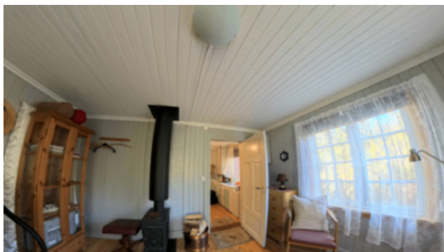
Bildet viser taket i stuen uten røykvarsler montert.
