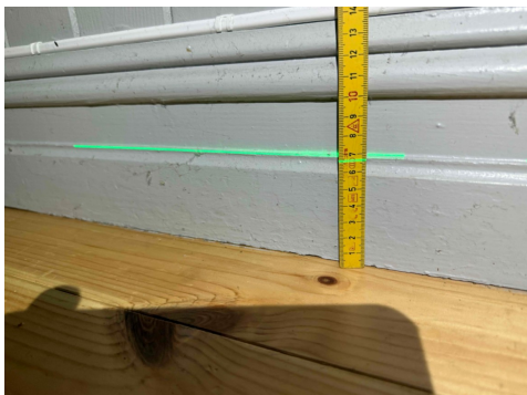
Bildet viser måling i stuen.
