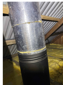
Bildet viser liten stålpipes med eksponert isolasjon.
