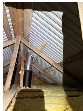
Bildet viser loft uten undertak under takplatene.
