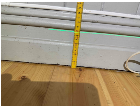
Bildet viser måling i stuen.
