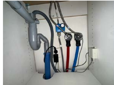
Røropplegg i kjøkkenbenk med Waterguard
