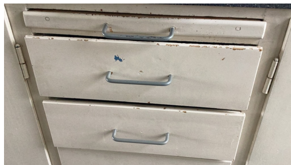
Eksempel på slitasje.
