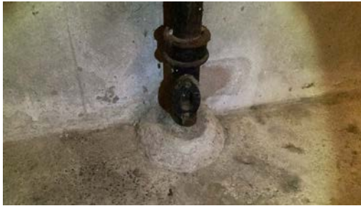
Stakepunkt i kjeller.
