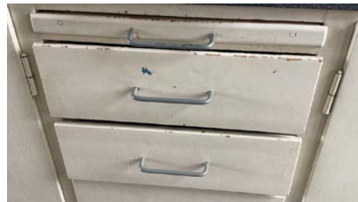
Eksempel på slitasje.
