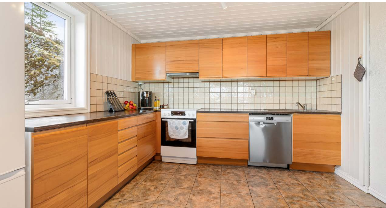
Kjøkkeninnredningen har glatte fronter og laminert benkeplate. På veggen mellom overskap og benkeplaten er det montert fliser.
