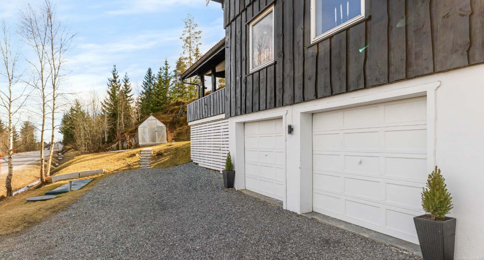
I underetasjen er det tilhørende dobbel garasje integrert i boligen.
