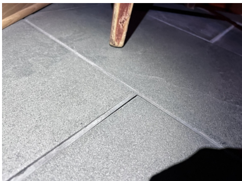
Bom (hullrom) i store deler av entre/gang og kombinert soverom/garderobe
