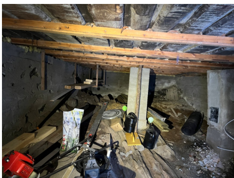
Krypkjeller med utvendig tilgang.
