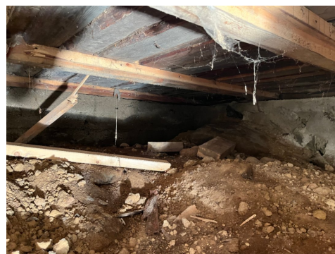
Kryp Kjeller mot nord/øst.
