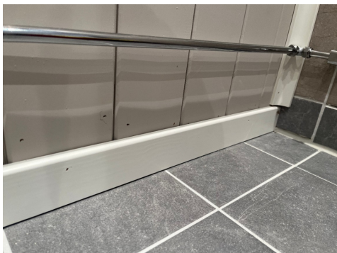
Overgang gulv/vegg har usikker løsning.
