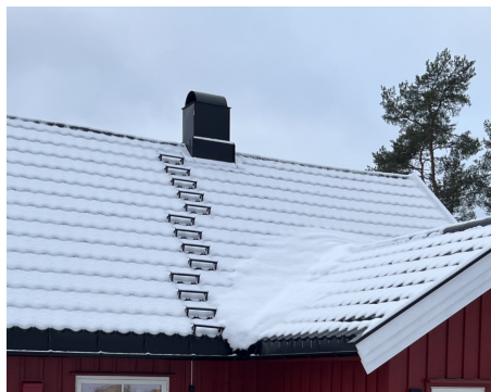
Snødekt tak med stigetrinn til pipe.
