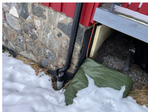
Synlig fuktsikring av grunnmur.
