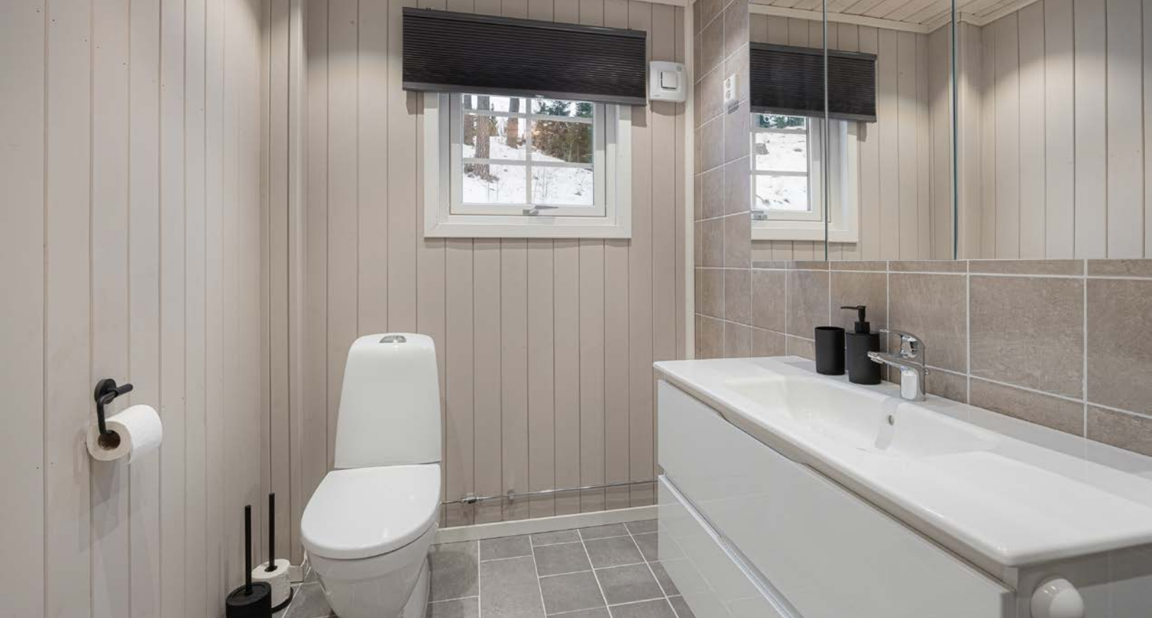
Rommet har fliser på gulv med gulvvarme, fliser og panel på vegger samt downlights i himling.
