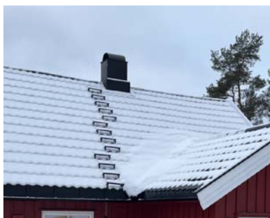
Snødekt tak med stigetrinn til pipe.
