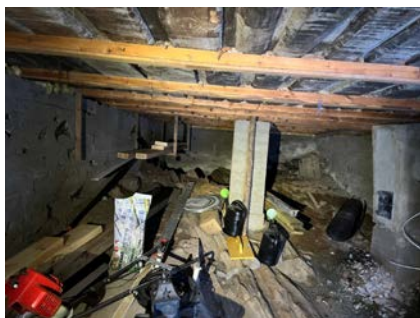
Krypkjeller med utvendig tilgang.
