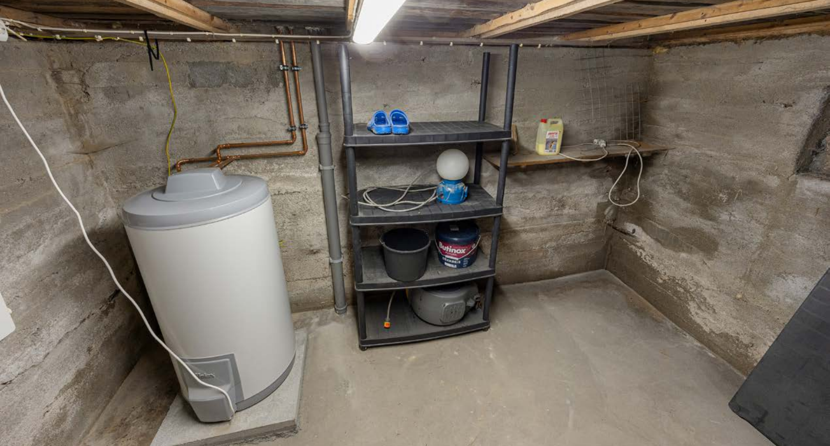
Under kjøkkenet er det et kjellerrom som benyttes som bod. Rommet har støpt plate på mark med sluk. Boligen har krypkjeller med både innvendig og utvendig adkomst.
