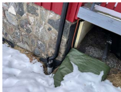
Synlig fuktsikring av grunnmur.
