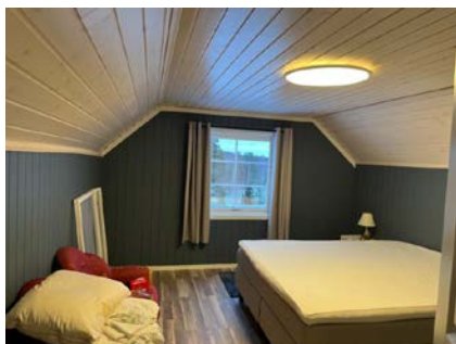
Mangelfull ventilasjon i bl.a. soverom
