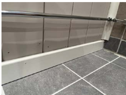
Overgang gulv/vegg har usikker løsning.
