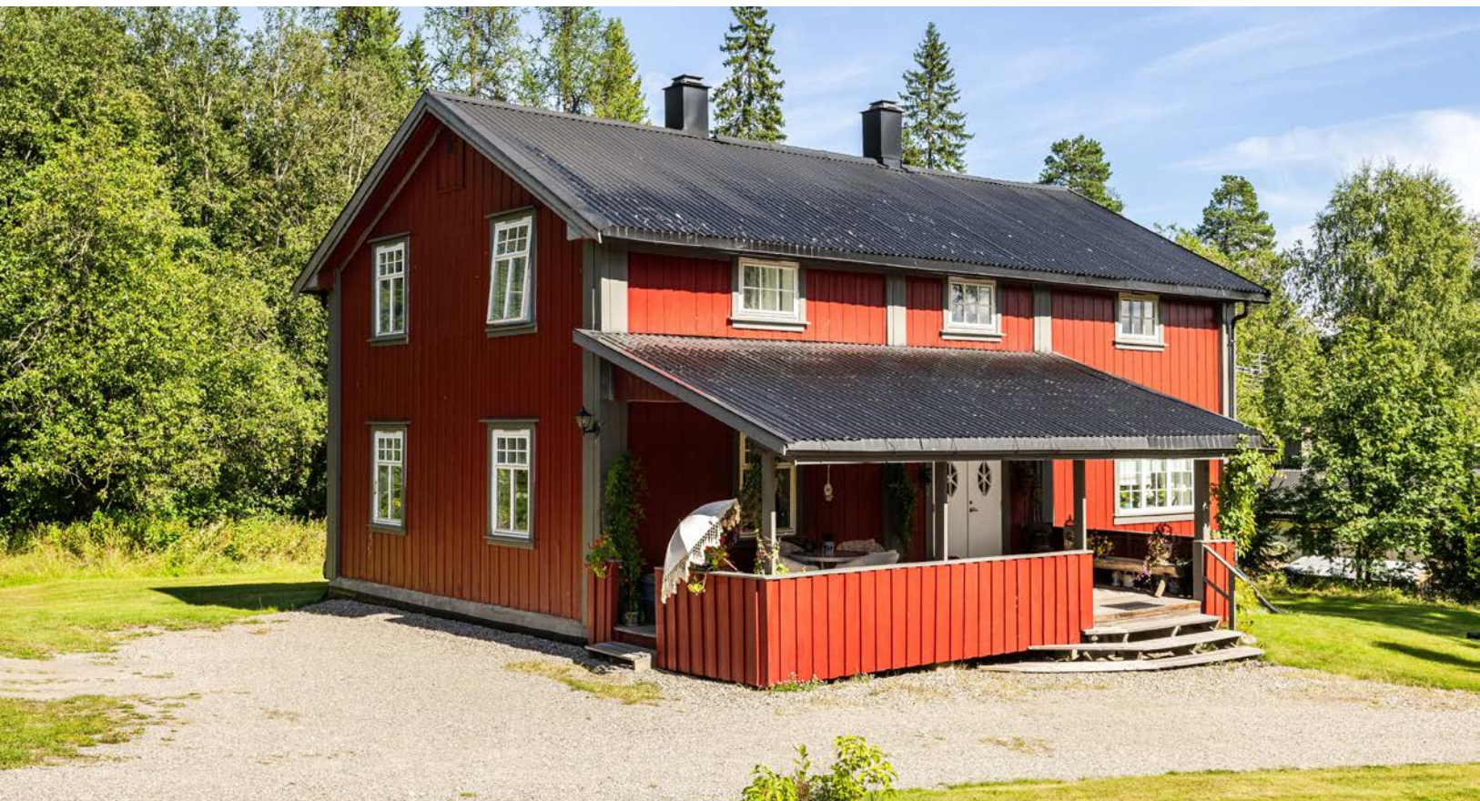
Et sjarmerende rødmalt hus! Kledningen er sist overflatebehandlet i 2022 og taktekingen ble lagt i 1988/89.
