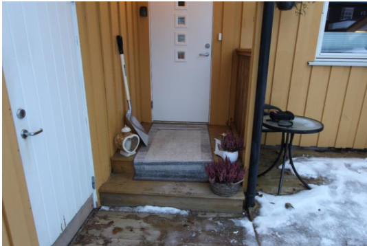
Trapp ved inngangen.
