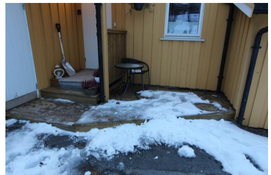
Terrasseplatter ved inngangen.
