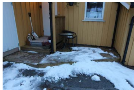
Terrasseplatter ved inngangen.
