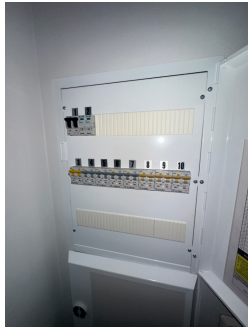
Sikringskap med automatsikringer.
