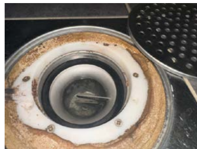
Sluk i rustfritt stål, plassert i dusjnise
