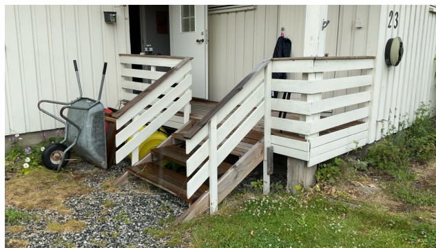
Besiktigelse av trapp.
