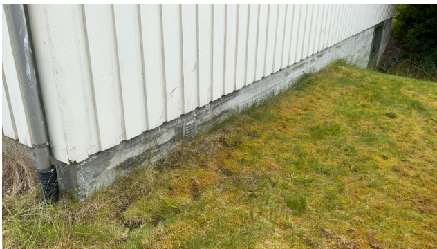
Kontroll av drenering/fuktsikring.
