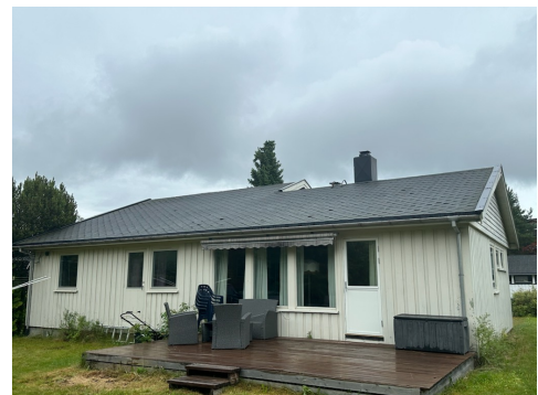
Besiktigelse av taktekke.
