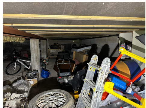
Besiktigelse av kryprom.
