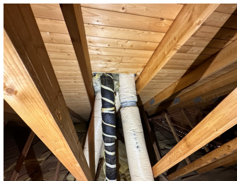
Kontroll rundt rørgjennomføringer.
