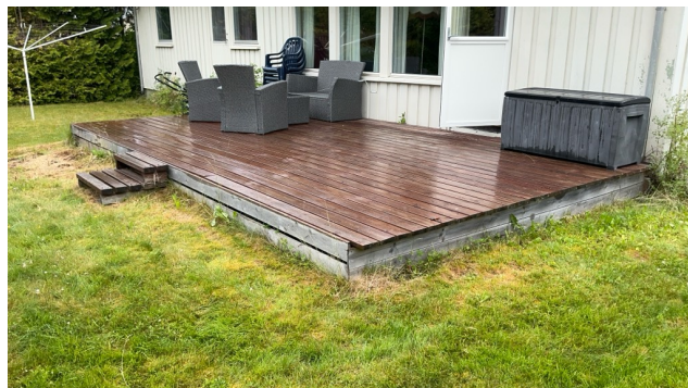
Besiktigelse av terrasse.
