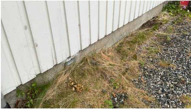
Kontroll av drenering/fuktsikring.
