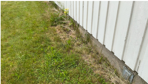
Kontroll av drenering/fuktsikring.
