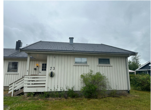
Besiktigelse av taktekke.
