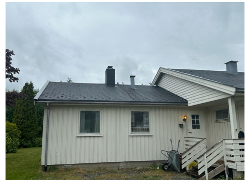
Besiktigelse av taktekke.
