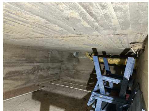
Besiktigelse av kryprom.
