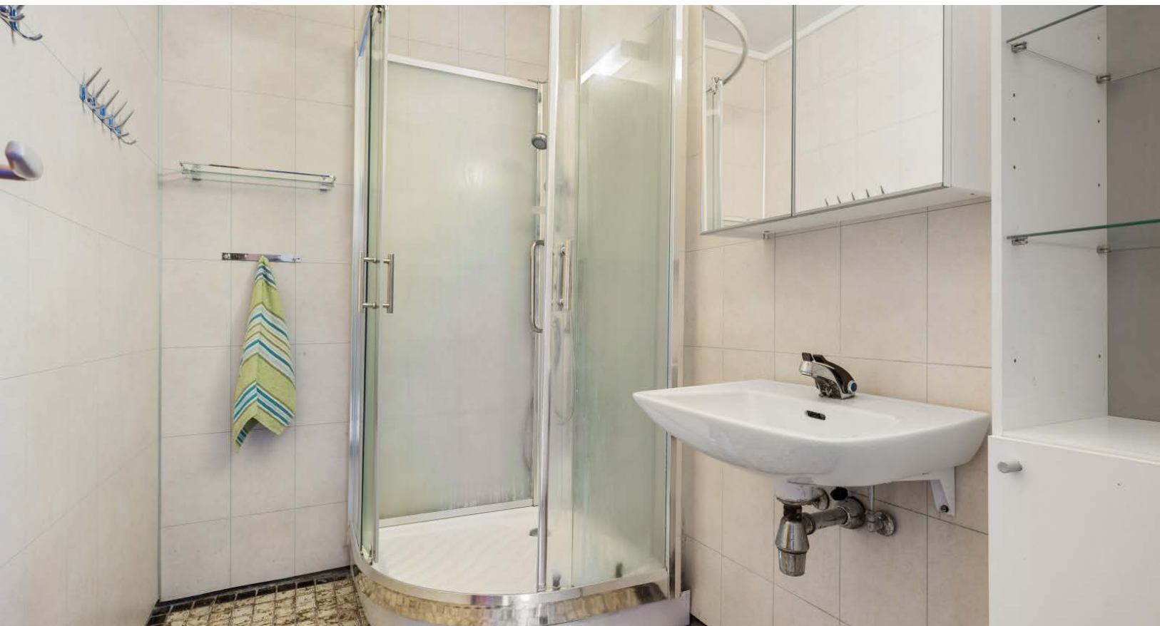
Baderommet har våtromsplater i flisimitasjon på vegger, originale gulvfliser m/gulvvarme, dusjkabinett speilskap, høyskap og servant.
