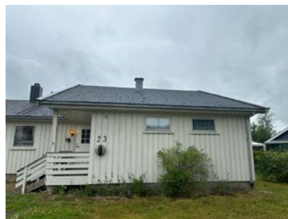
Besiktigelse av taktekke.
