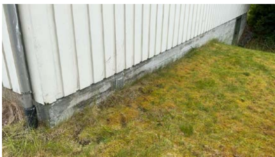
Kontroll av drenering/fuktsikring.
