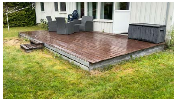
Besiktigelse av terrasse.
