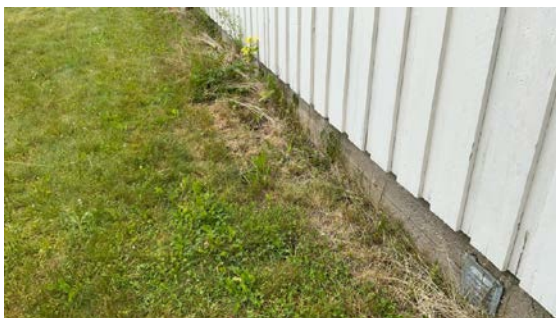
Kontroll av drenering/fuktsikring.
