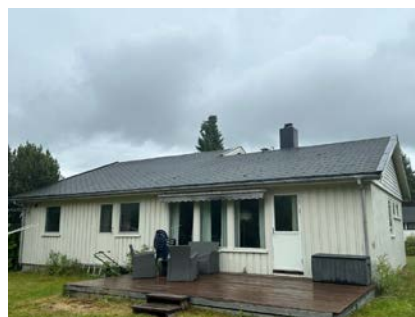
Besiktigelse av taktekke.
