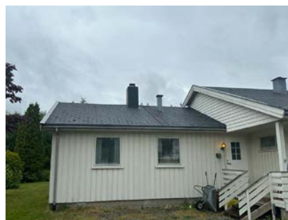
Besiktigelse av taktekke.
