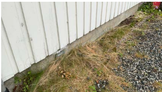
Kontroll av drenering/fuktsikring.
