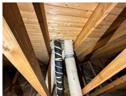
Kontroll rundt rørgjennomføringer.
