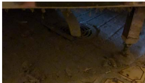
Kontroll av sluk.
