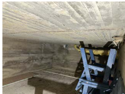
Besiktigelse av kryprom.
