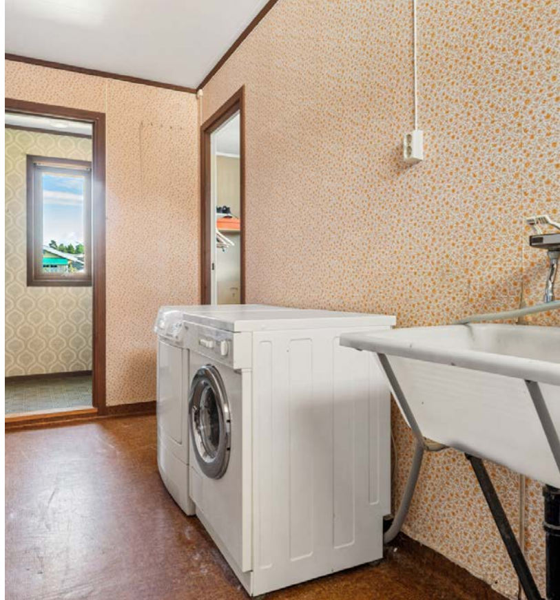
Vaskerom med linoleumsbelegg m/gulvvarme, nyere varmtvannsbereider og installert vannmåler.
