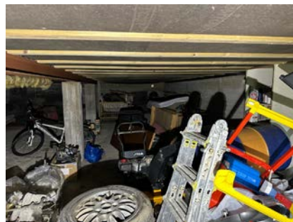
Besiktigelse av kryprom.
