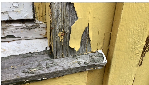
Omramming rundt vinduer er ført helt ned til vannbrett.
