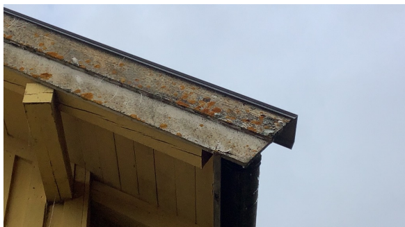
Råteskadet vindski.
