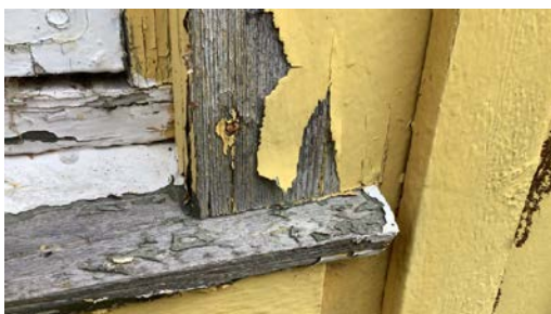
Omrømming rundt vinduer er ført helt ned til vannbrett.
