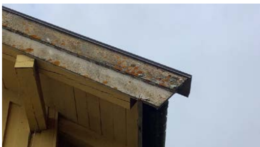
Råteskadet vindski.
