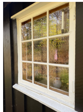
Karmene i vinduer er slitte og det er sprekker i trevirket.
