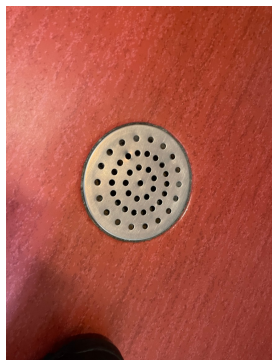
Ufaglig tetting rundt rørgjennomføringer i gulv
