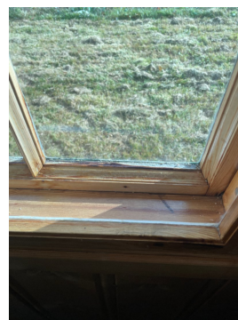
Karmene i vinduer er slitte og det er sprekker i trevirket.
