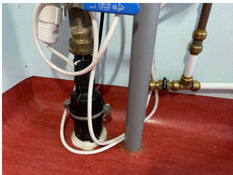
Ufaglig tetting rundt rørgjennomføringer i gulv
