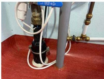
Ufaglig tetting rundt rørgjennomføringer i gulv
