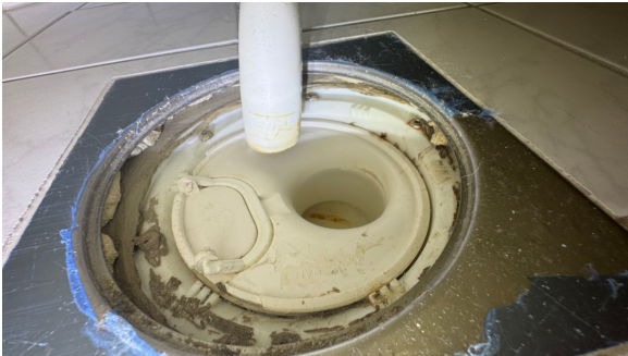
Kontroll av sluk.
