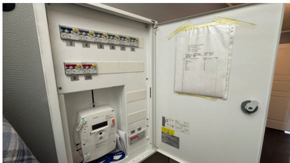
Kontroll av el-skap og kursfortegnelse.
