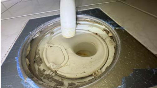
Kontroll av sluk.
