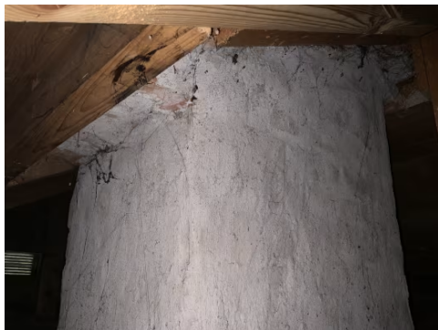
Viser takgjennomføring på kaldtloft.
