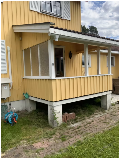
Viser takflate med manglende nedløpsrør.
