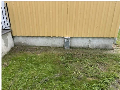
Viser del av grunnmur med kjeller.
