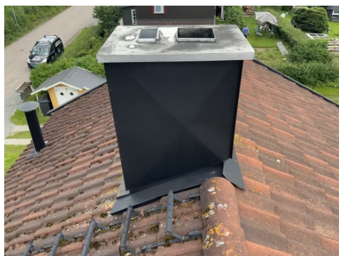
Viser pipe og pipebeslag på tekking.
