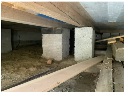
Viser del av krypprommet.
