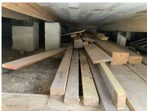
Viser del av krypprommet.
