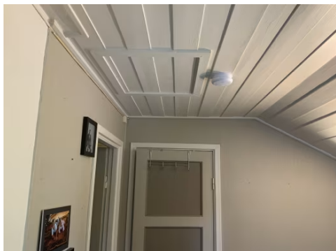
Viser tilkomst til luke i himling i gang/trapperom 2. etasje.
