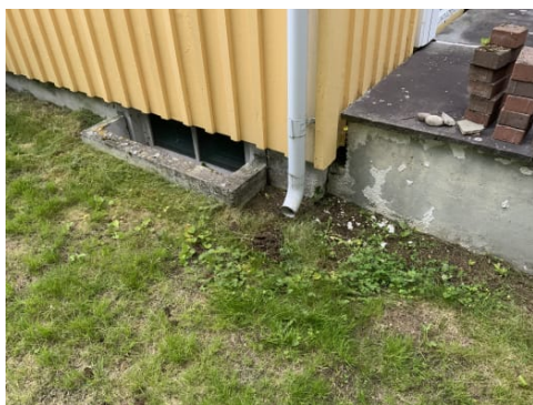
Viser taknedløp som er avsluttet over bakken.
