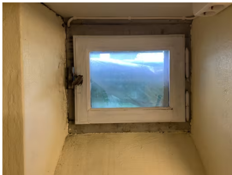
Viser vindu i kjeller fra byggeår.
