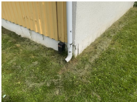
Viser taknedløp som er avsluttet over bakken.
