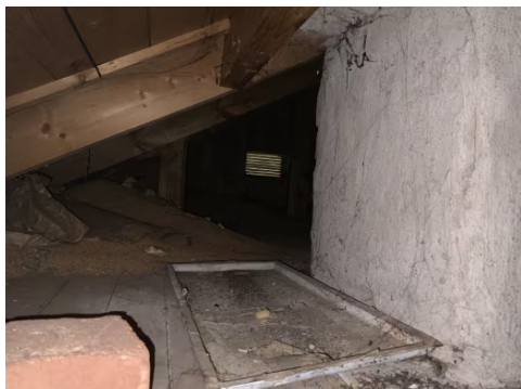
Viser del av kaldtloft.
