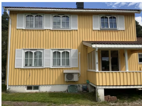
Viser del av fasade.
