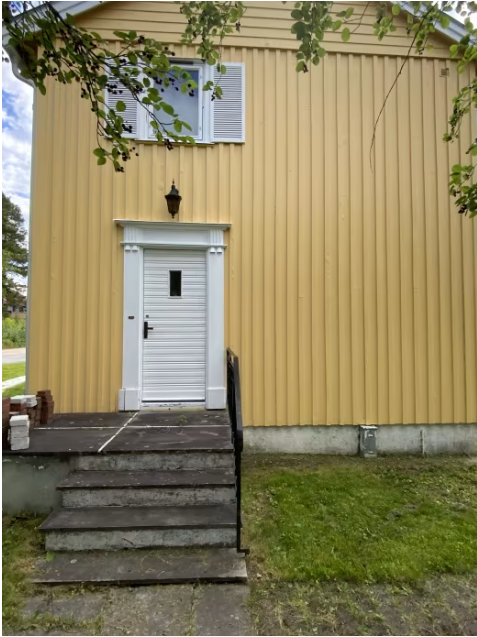
Viser del av fasade.
