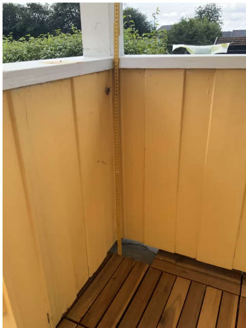
Viser målt rekkverkshøyde, høyde målt til 72 cm.
