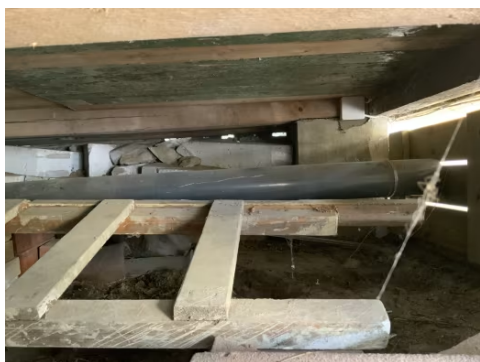
Viser del av krypprommet.
