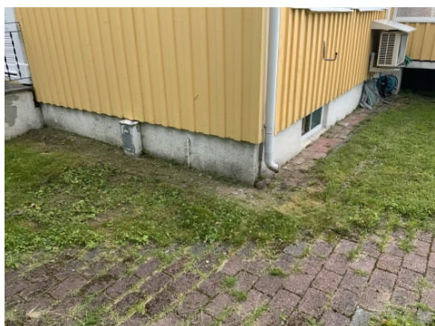
Viser taknedløp som er avsluttet over bakken.
