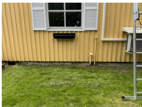
Viser del av grunnmur med kjeller.
