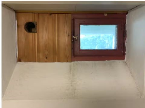
Viser vindu i kjeller fra byggeår.
