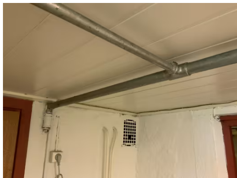
Viser vannrør fra byggeår i jern.
