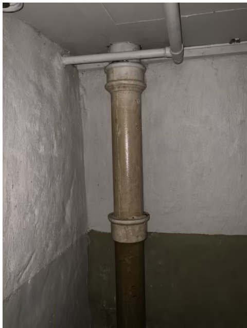
Viser avløpsrør av jern.
