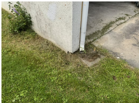
Viser taknedløp som er avsluttet over bakken.
