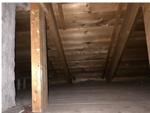
Viser del av kaldtloft.
