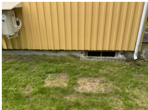
Viser del av grunnmur med kjeller.
