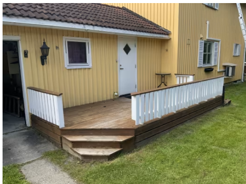
Viser østvendt terrasse på ca. 13 kvm i trekonstruksjoner, fundamentert på betongpilarer.
