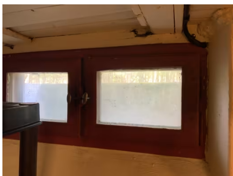
Viser vindu i kjeller fra byggeår.
