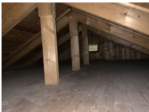
Viser del av kaldtloft.
