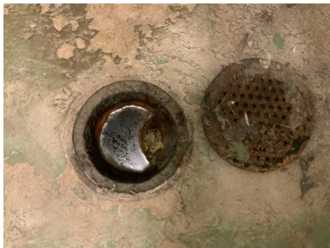
Viser sluk i vaskerom.
