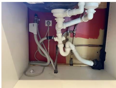
Viser vann- og avløpsinstallasjoner under kum.
