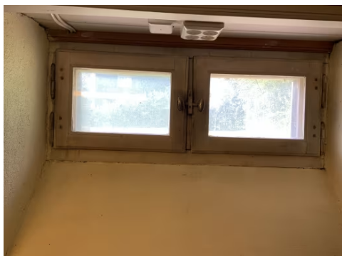
Viser vindu i kjeller fra byggeår.
