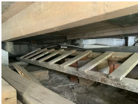
Viser del av krypprommet.
