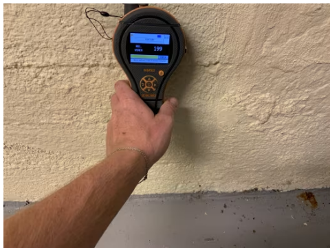
Viser fuktsøk på fritt eksponert vegg.
