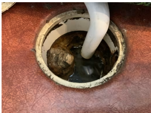
Viser støpejernsluk fra byggeår, forhøyningsring og klemring.
