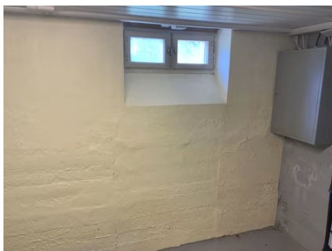
Viser område hvor det er utført fuksøk.
