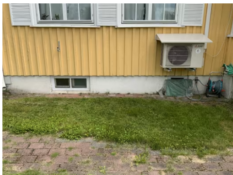
Viser del av grunnmur med kjeller.
