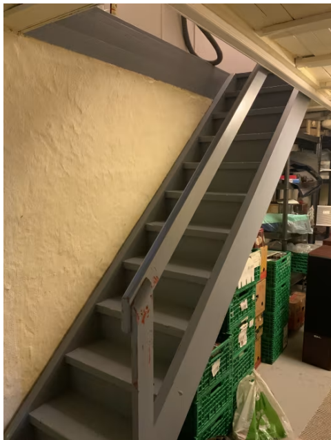
Viser trapp til kjeller.
