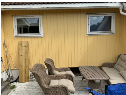
Viser del av fasade.
