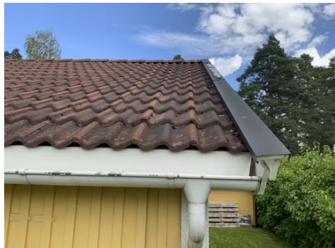
Viser del av taktekking.
