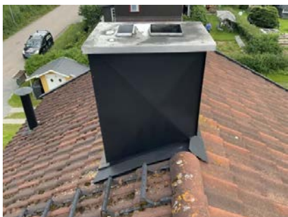
Viser pipe og pipebeslag på tekking.
