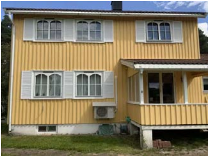
Viser del av fasade.
