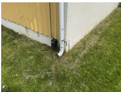
Viser taknedløp som er avsluttet over bakken.
