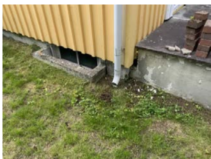
Viser taknedløp som er avsluttet over bakken.
