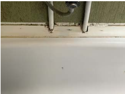
Viser bruk av organiske materialer i våtsone.
