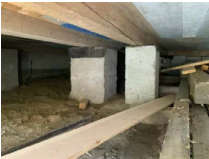
Viser del av kryprommet.
