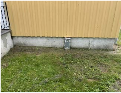
Viser del av grunnmur med kjeller.
