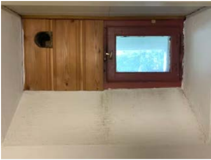
Viser vindu i kjeller fra byggeår.
