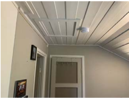
Viser tilkomst til luke i himling i gang/trapperom 2. etasje.
