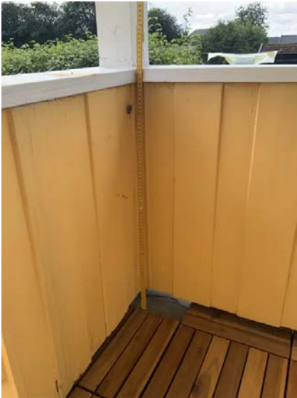
Viser målt rekkverkshøyde, høyde målt til 72 cm.
