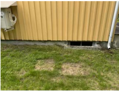
Viser del av grunnmur med kjeller.
