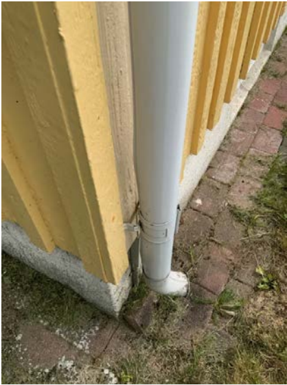
Viser buling/skade.
