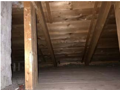
Viser del av kaldtloft.
