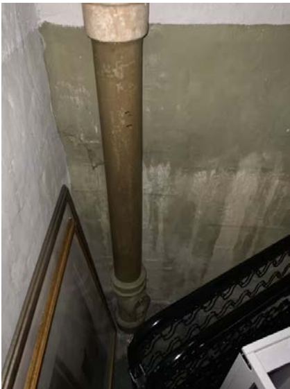
Viser plassering av stakeluke i kjeller.
