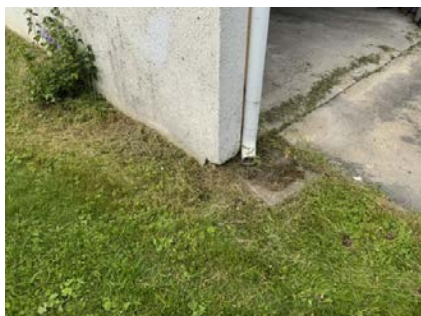
Viser taknedløp som er avsluttet over bakken.
