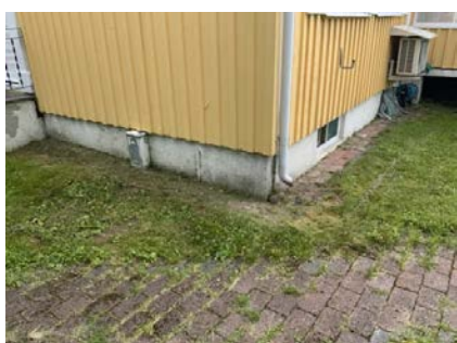
Viser taknedløp som er avsluttet over bakken.
