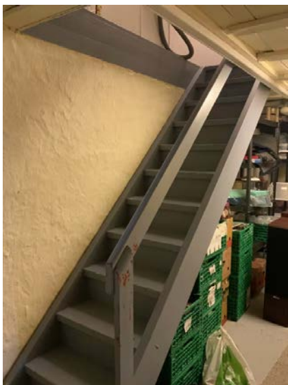
Viser trapp til kjeller.
