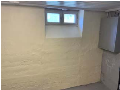
Viser område hvor det er utført fuktsøk.
