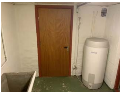
Viser varmtvannsbereider.
