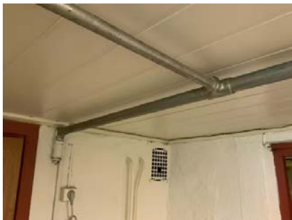
Viser vannrør fra byggeår i jern.
