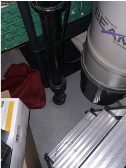
Viser plassering av stakeluke i kjeller.
