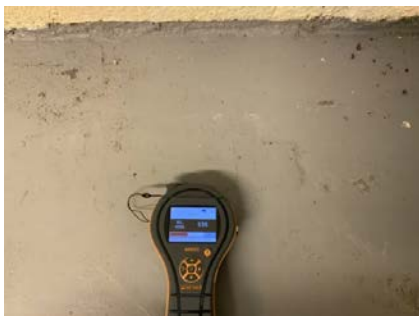
Viser fuktsøk på fritt eksponert gulv.
