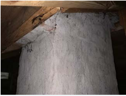
Viser takgjennomføring på kaldtloft.
