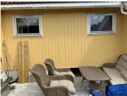
Viser del av fasade.
