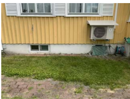
Viser del av grunnmur med kjeller.
