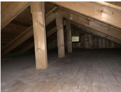
Viser del av kaldtloft.
