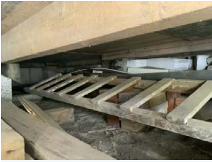
Viser del av kryprommet.
