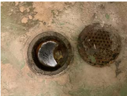
Viser sluk i vaskerom.
