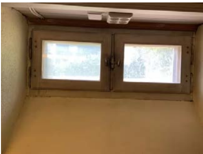
Viser vindu i kjeller fra byggeår.
