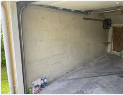
Viser yttervegg garasje av murte lettklinkerblokker (Leca), med utvendig murpuss.
