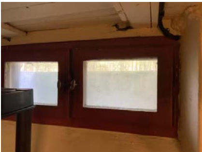
Viser vindu i kjeller fra byggeår.
