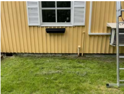
Viser del av grunnmur med kjeller.
