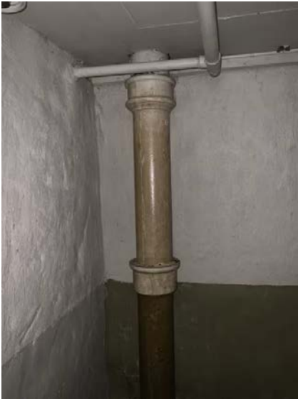
Viser avløpsrør av jern.
