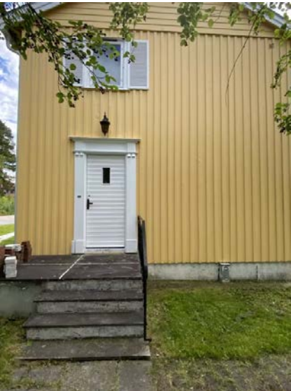
Viser del av fasade.
