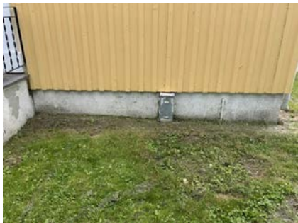
Viser del av grunnmur med kjeller.
