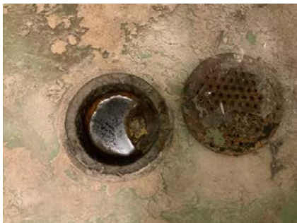
Viser sluk i vaskerom.
