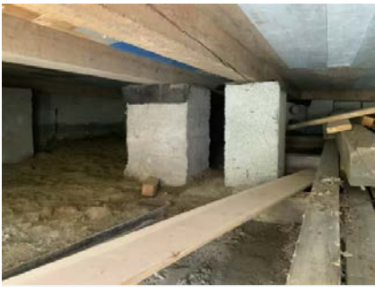
Viser del av kryprommet.
