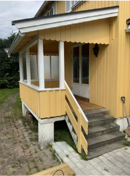
Viser vestvendt overbygget terrasse på ca. 5 kvm i betong og trekonstruksjoner, fundamentert på betongpilarer.
