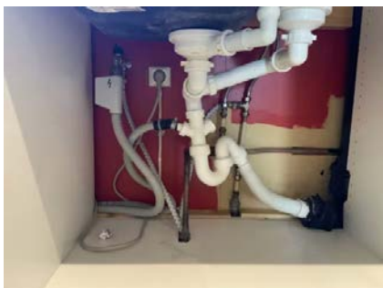
Viser vann- og avløpsinstallasjoner under kum.
