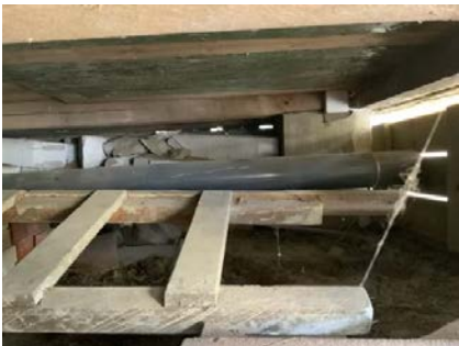
Viser del av kryprommet.
