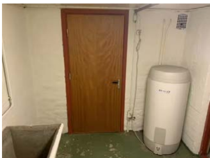
Viser varmtvannsbereider.
