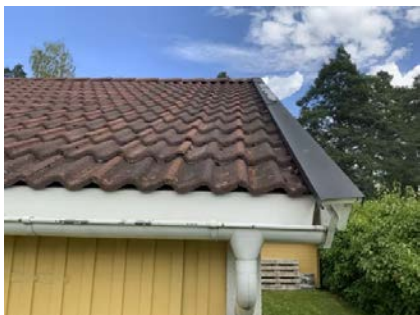
Viser del av takteking.
