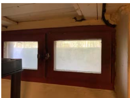
Viser vindu i kjeller fra byggeår.
