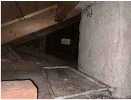
Viser del av kaldtloft.
