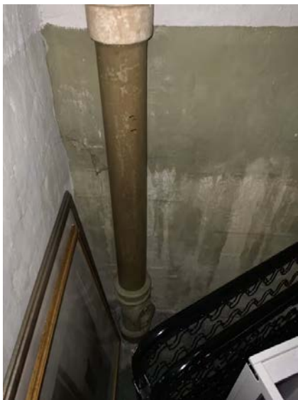
Viser plassering av stakeluke i kjeller.
