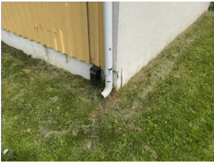
Viser taknedløp som er avsluttet over bakken.
