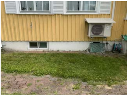
Viser del av grunnmur med kjeller.
