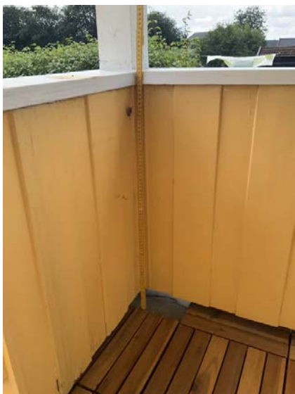
Viser målt rekkverkshøyde, høyde målt til 72 cm.
