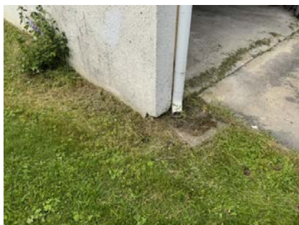
Viser taknedløp som er avsluttet over bakken.
