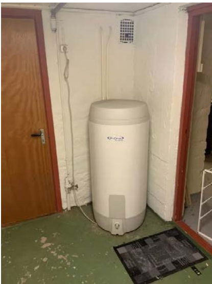
Viser plassering av varmtvannsbereder i kjeller.
