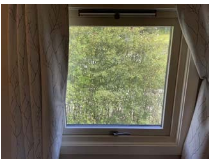
Viser eksempel av vindu i boligen.
