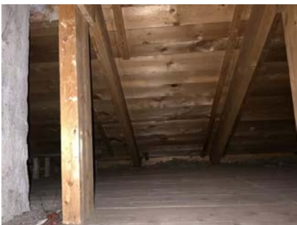
Viser del av kaldtloft.
