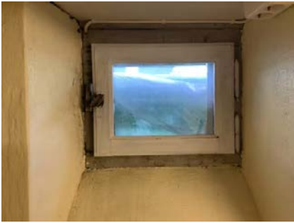
Viser vindu i kjeller fra byggeår.
