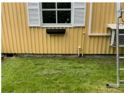
Viser del av grunnmur med kjeller.
