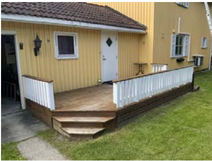
Viser østvendt terrasse på ca. 13 kvm i trekonstruksjoner, fundamentert på betongpilarer.
