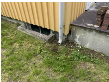
Viser taknedløp som er avsluttet over bakken.
