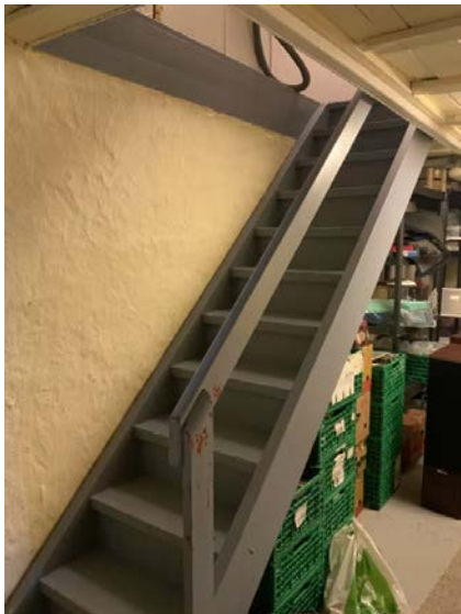
Viser trapp til kjeller.
