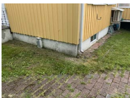
Viser taknedløp som er avsluttet over bakken.
