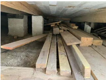
Viser del av kryprommet.
