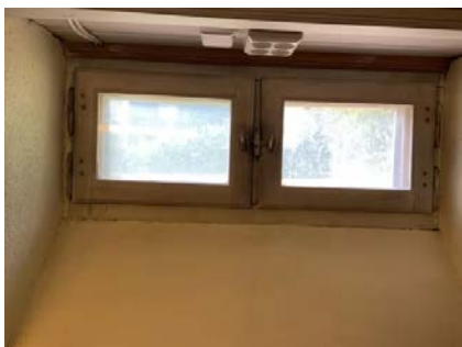
Viser vindu i kjeller fra byggeår.
