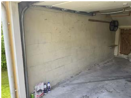
Viser yttervegg garasje av murte lettklinkerblokker (Leca), med utvendig murpuss.
