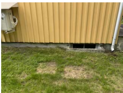
Viser del av grunnmur med kjeller.
