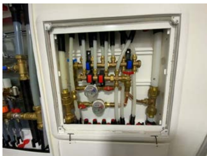
Besiktigelse av røropplegg.
