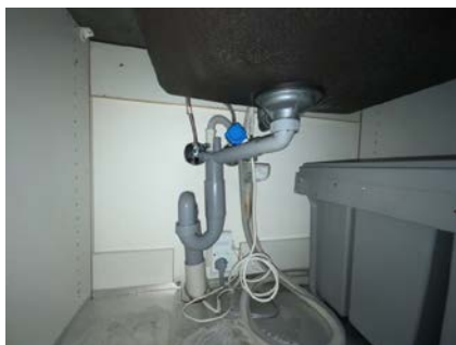
Besiktigelse av røropplegg.
