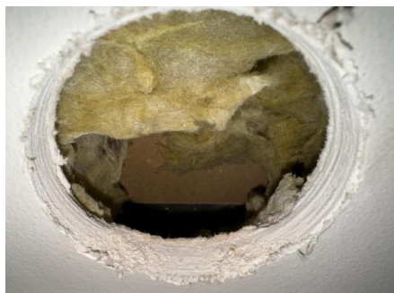
Hulltaking i tilstøtende soverom
