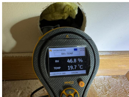
Hulltaking i tilstøtende soverom
