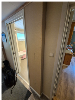
Manglende overflate behandling av veggplater i gang.
