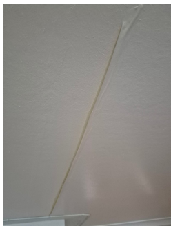
Manglende overflate behandling av veggplater i gang.
