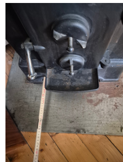
Plate på gulv går ikke 30 cm ut fra åpning.
