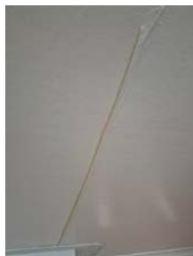
Manglende overflate behandling av veggplater i gang.
