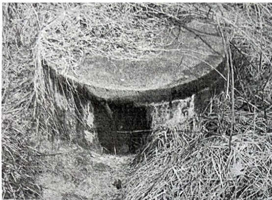
Et avløpsanlegg som ikke fungerer kan se slik ut.
