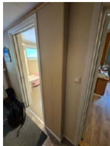
Manglende overflate behandling av veggplater i gang.
