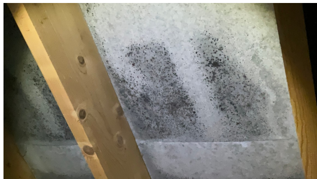
Spor etter kondens på undertak sett fra kryploft
