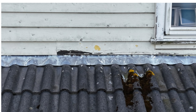
Råteskadet kledning
