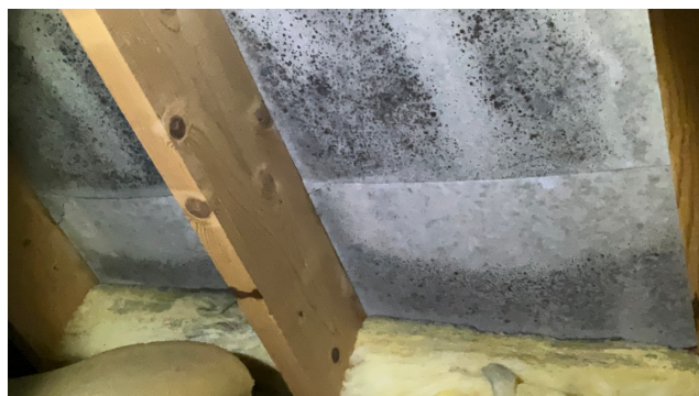
Spor etter kondens på undertak sett fra kryploft
