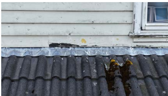
Råteskadet kledning
