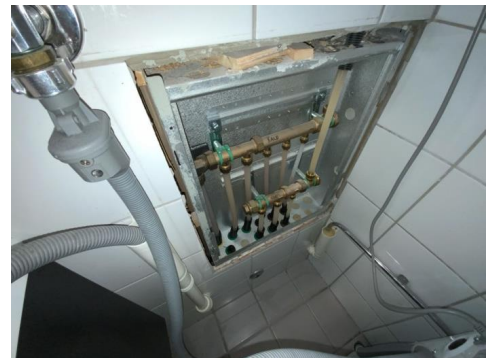
Besiktigelse av røropplegg.
