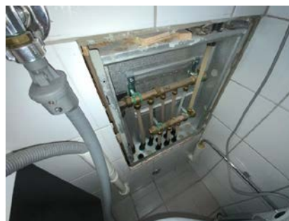
Besiktigelse av røropplegg.
