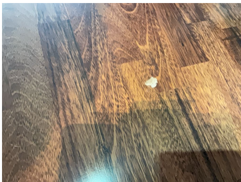
Hakk i gulv i stue/kjøkken.
