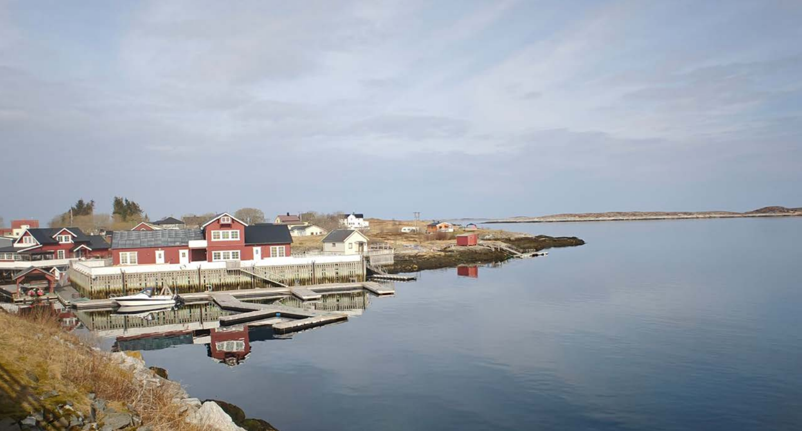
Område rundt brygga. Bildet er tatt fra bilveien, retning nord.
