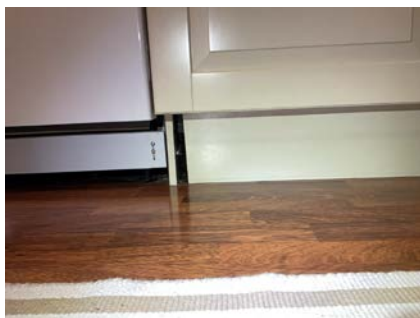
Sokkel mot gulv passer ikke helt.
