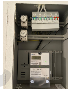
Sikringskap med skru/ automatsikringer.
