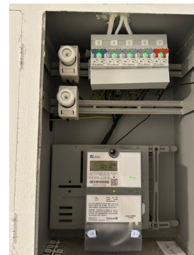
Sikringsskap med skru/automatsikringer.
