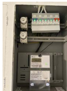
Sikringsskap med skru/ automatsikringer.
