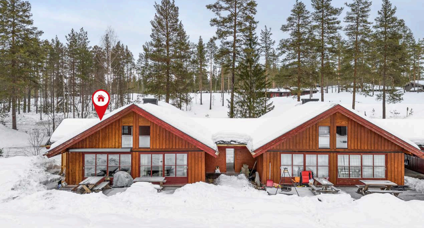
Fasade, enheten ligger på enden - til venstre i bildet.
