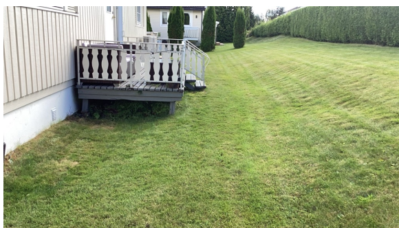
Bilde fra vestsiden av boligen.
