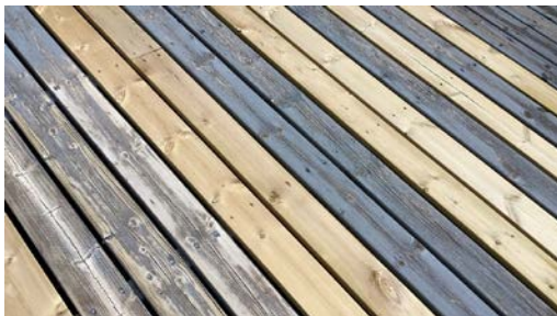
Det er skiftet ut enkelte gulvbord på hovedveranda.
