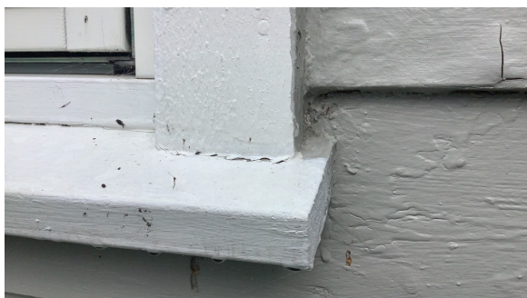
Omramming er stedvis ført helt ned til vannbrett.
