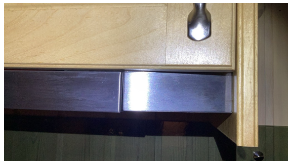
Skapdør over ventilator må justeres litt.
