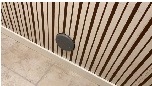
Stakeluke på bod i underetasje.
