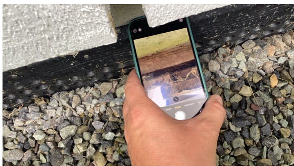
Sjekk av lufting.
